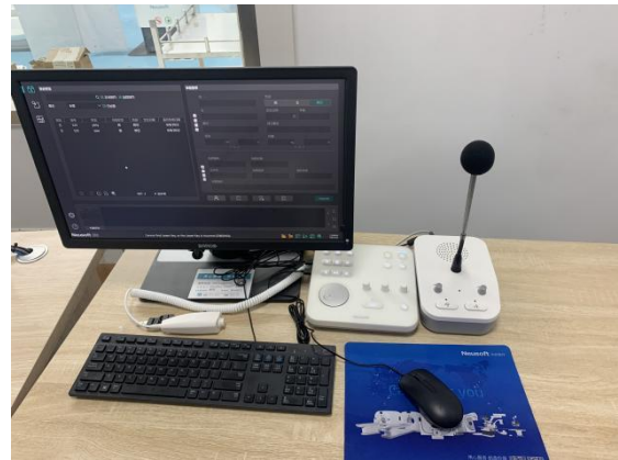
控制室对讲装置
