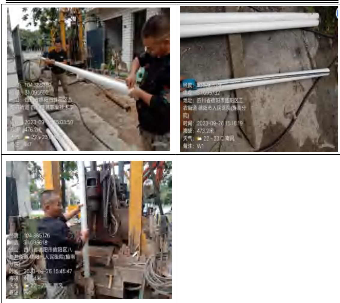
图 3.2-7 地下水建井下管照片
