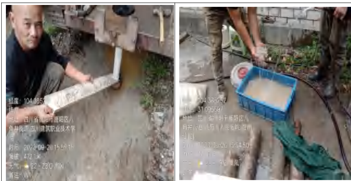
图 3.2-8 地下水建井填充滤料照片
