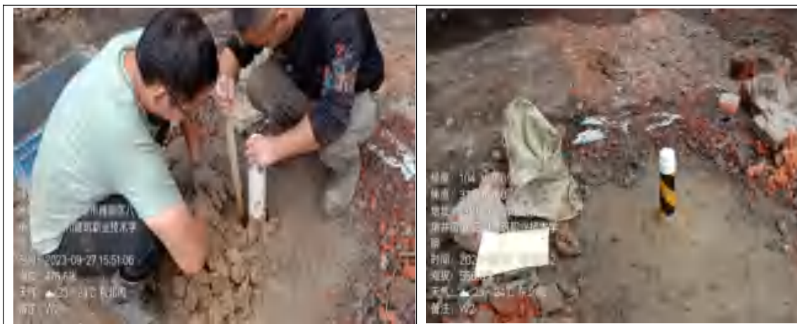
图 3.2-9 地下水建井密封止水照片
