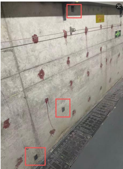
辐照室红外光电联锁装置
