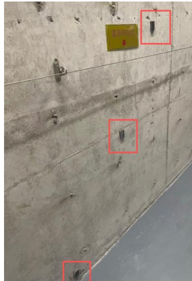
主机室红外光电联锁装置
