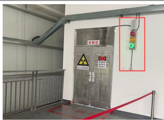
主机室门口灯光和音响警示信号
