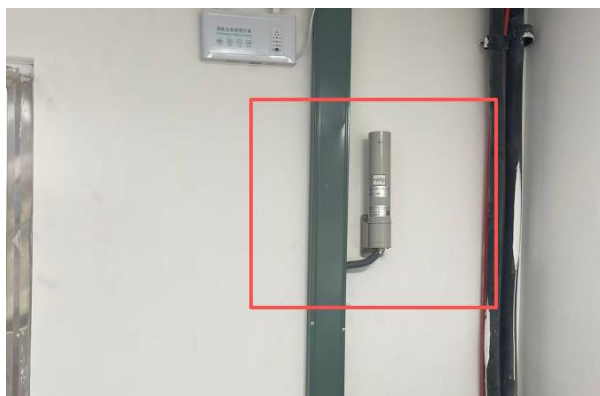
控制室内剂量探头
